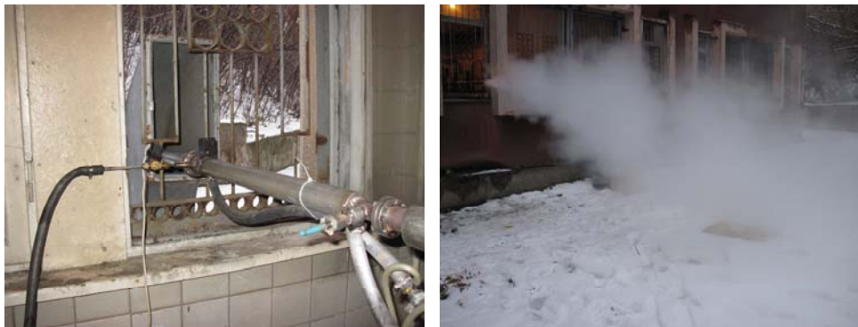
Рисунок 2 – Общий вид ствола установки пожаротушения
