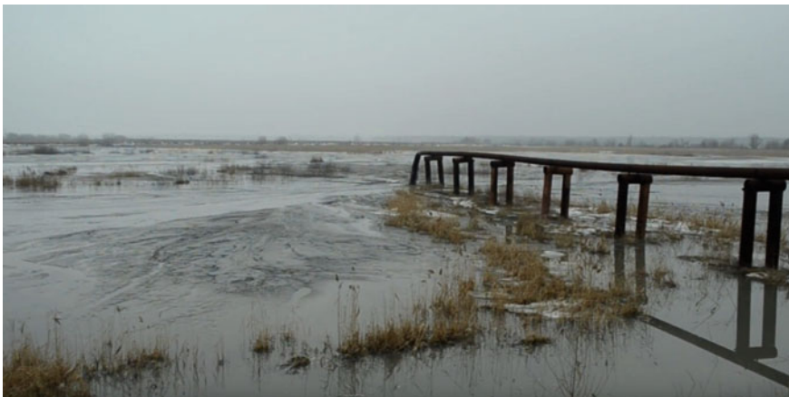
Fig. 1 Ash-slag dump of Dobrotvor TPP
