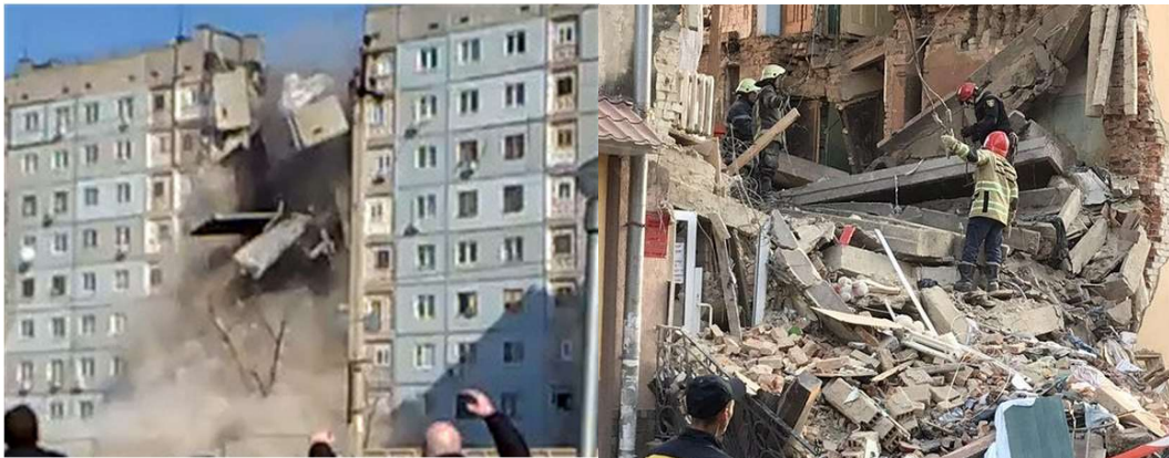
Рисунок 2 – Вибух газоповітряної суміші у житловому секторі
