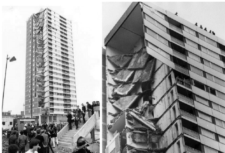
Рисунок 2. Руйнування секції будинку Ронан-Пойнт, 1968 рік
