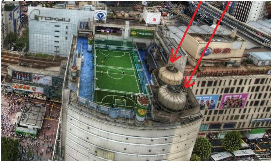
Рис. 1. Торговельний центр обладнаний пожежними резервуарами на покрівлі в Токіо
