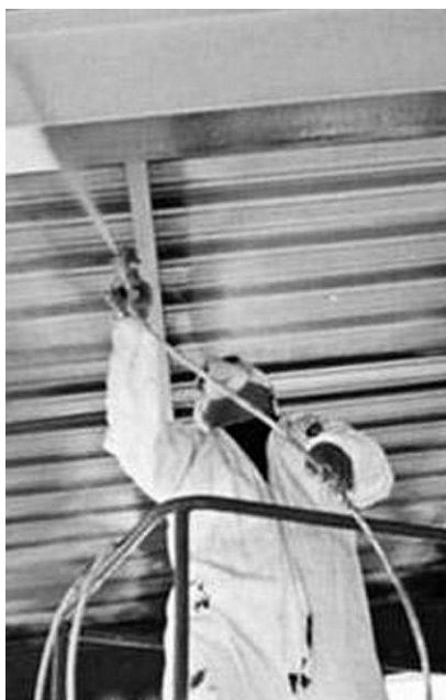
Рисунок 7.5 — Нанесення вогнезахисної фарби
