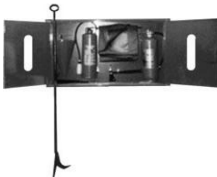
Рисунок 30.2 – Пожежний щит закритого типу
