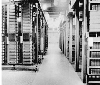
Рис. 15 – 4 Комутаційне обладнання автоматної зали
