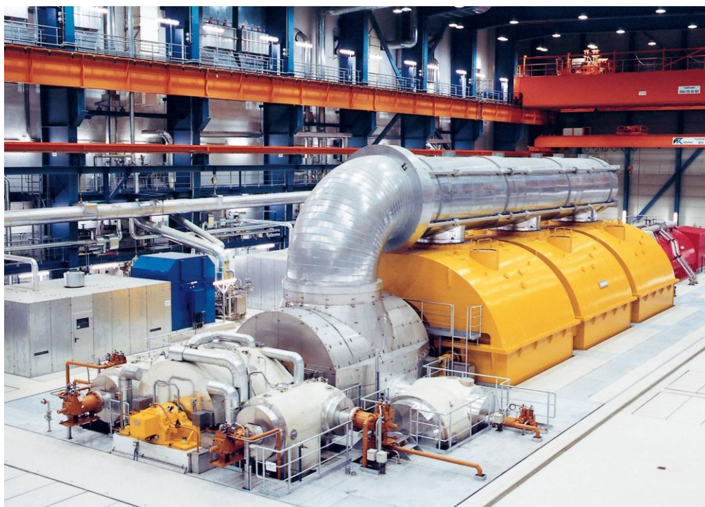
Рис. 2.1- Генератор з водневою системою охолодження
