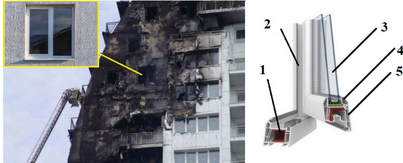
Рис. 1. Фото фасадної пожежі, що супроводжувалася руйнуванням вікна та основні елементи склопакетів: 1 – металопластиковая рама (профіль); 2 – гумовий ущільнювач; 3 – склопакет; 4 – ущільнювач-замок; 5 – зовнішня рама стулки.
