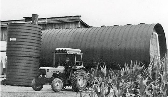
Рис. 8. Спірально-фальцевий метантенк із горизонтальним процесом ферментації
