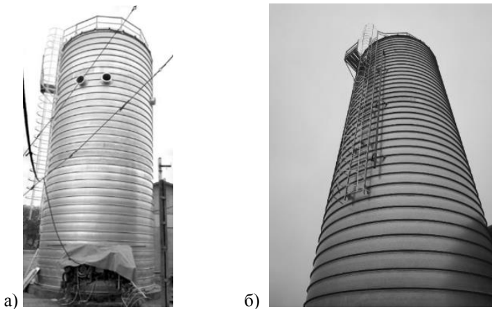
Рис. 6. Спірально-фальцевий силос для зберігання тріски: а) м. Чернівці; б) м. Полтава
