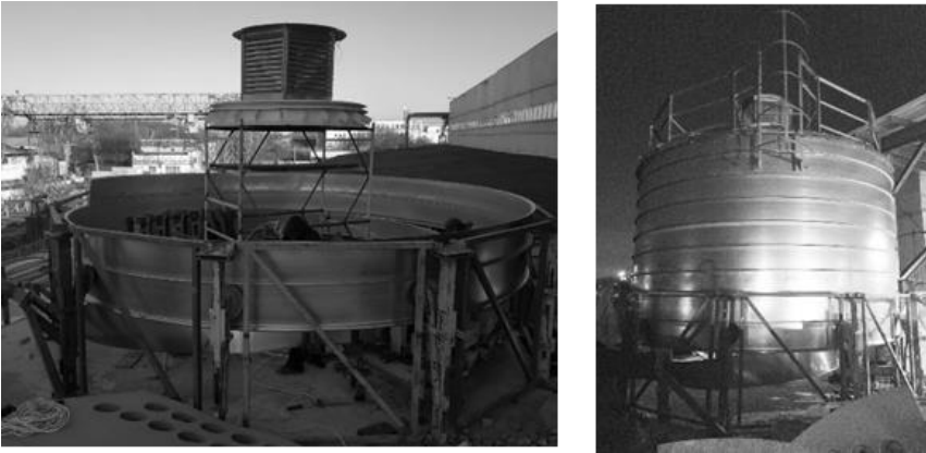
Рис.2. Монтаж спіральньо-фальцевого силосу для тріски деревини, м. Полтава
