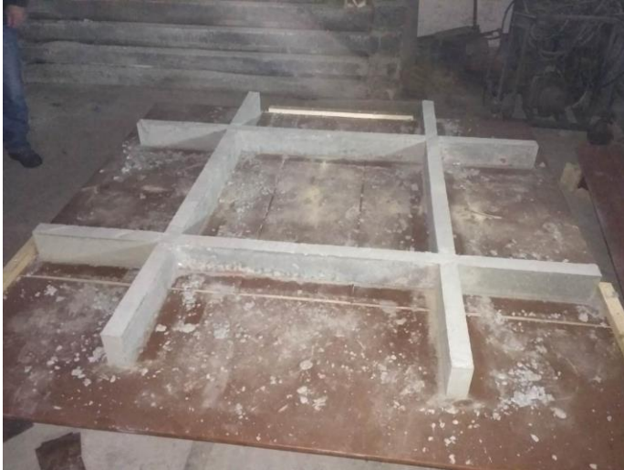
Рис. 8. Загальний вигляд готової перехресно-балкової системи
