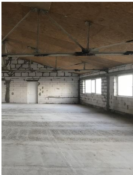
Фото 2. Видгляд влаштованої сталеві-залізобетонної конструкції перекриття
