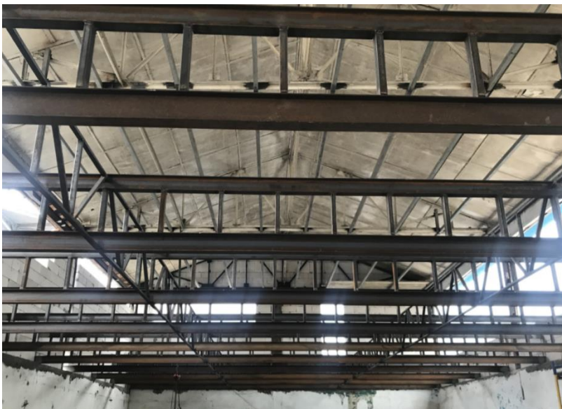
Фото 1. Металеві ферми конструкції комбінованого сталеві-залізобетонного перекриття на стадії монтажу
