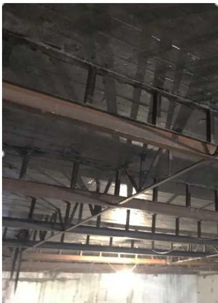
Фото 2. Видгляд влаштованої сталеві-залізобетонної конструкції перекриття
