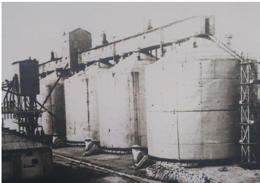
Рис. 1. Вид на группу металлических силосов на Дрокиевском ХПП (Республика Молдова) с восточного направления
