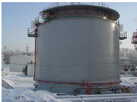
Рис. 1. Резервуар с защитной кольцевой стенкой
