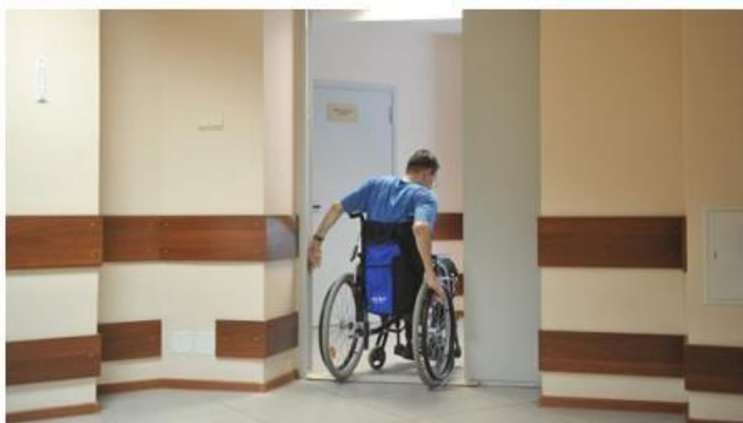
Рис. А13. Зразок оздоблення стін захисними панелями
