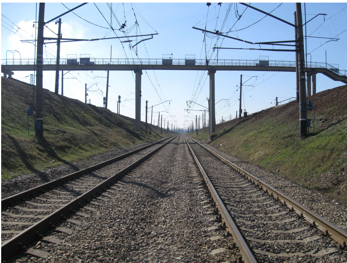
Рис. 3.1. Пример выемки, ограничивающей область возможного растекания жидкости
