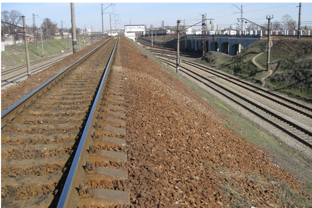
Рис. 2.4. Пример высокой насыпи, обеспечивающей стекание жидкости на значительное расстояние от места аварии
