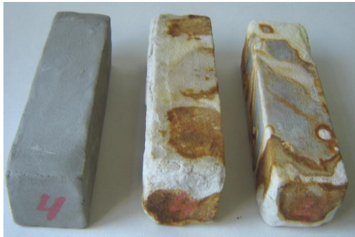
Рисунок 4.5 – Зразки захисного покриття бетону (зліва направо: контрольний зразок, зразки після експозиції в каналізаційному колекторі)
