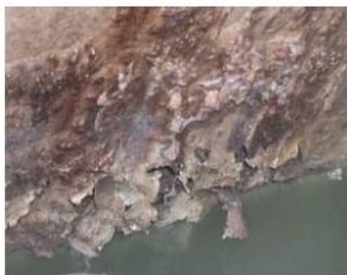
Рисунок 1.8 – Візуальні пошкодження захисних покриттів після їх нанесення на ділянки бетонних споруд водовідведення:
