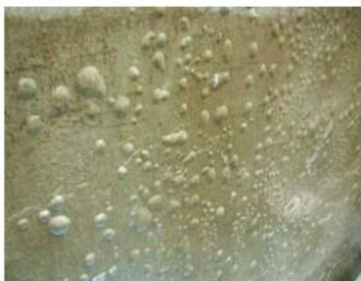
Рисунок 1.8 – Візуальні пошкодження захисних покриттів після їх нанесення на ділянки бетонних споруд водовідведення:
