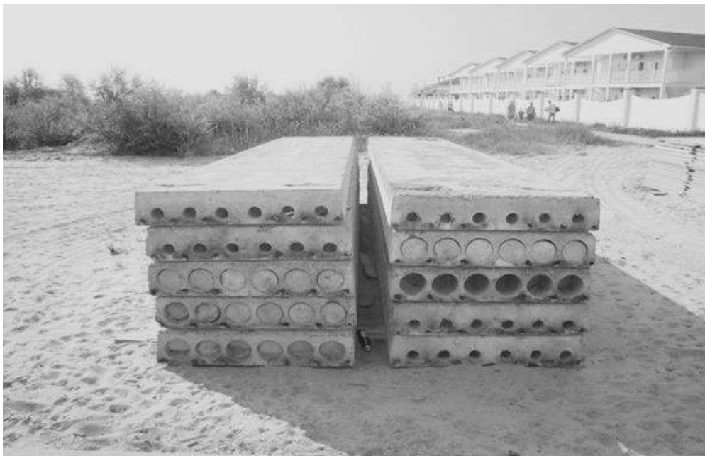
Рис. 1. Загальний вигляд залізобетонної багатопустотної плити перекриття.
