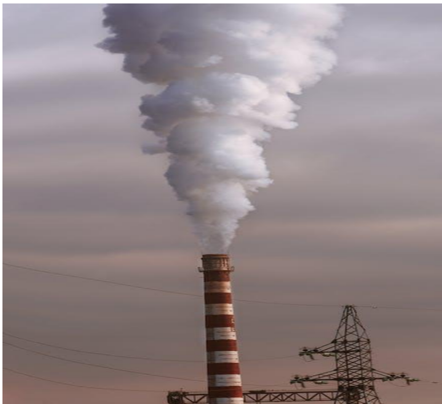
Рисунок 5 – Приклад точкового джерела забруднення (труба)
