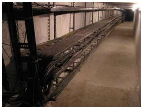
Рис. 1. Приклад кабельного тунелю прямокутного перерізу
