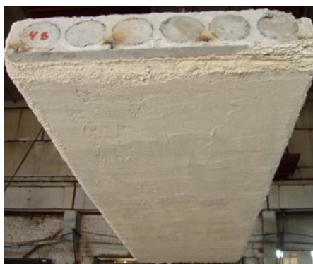
Рис. 1 – Вид многопустотного железобетонного перекрытия с огнезащитным покрытием до испытания.
