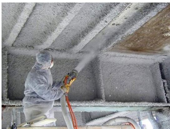
Рис.1. Процес проведення вогнезахисту металевих конструкцій та захищена вогнезахисним шаром металева конструкція
