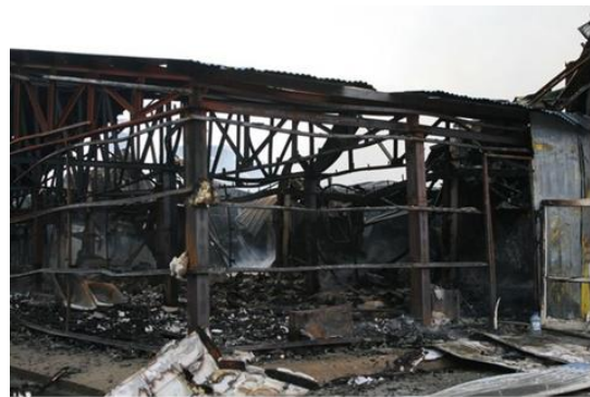
Рис.1. Вплив вогню на будівельні конструкції та результат (їх деформація)
