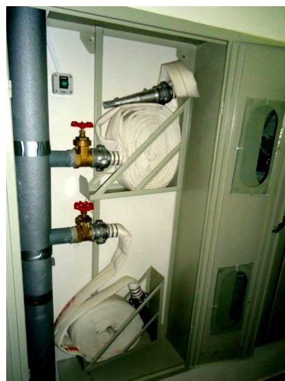
Рис. 2.50 – Пожежні кран-комплекти:
