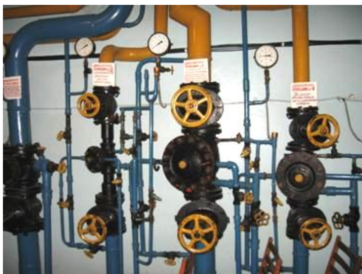
Рис. 2.66 – Вузол керування установкою автоматичного пожежогасіння палацу культури
