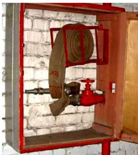
Рис. 2.50 – Пожежні кран-комплекти:
