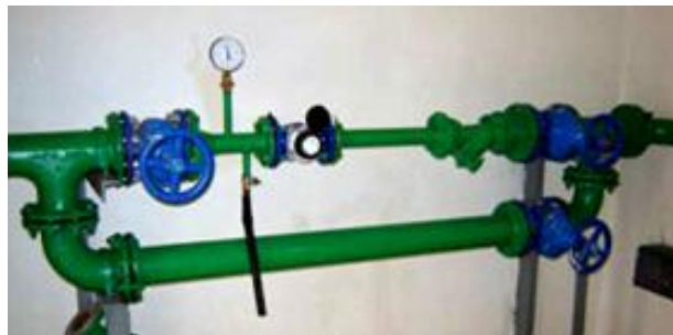
Рис. 2.45 – Водомірний вузол
