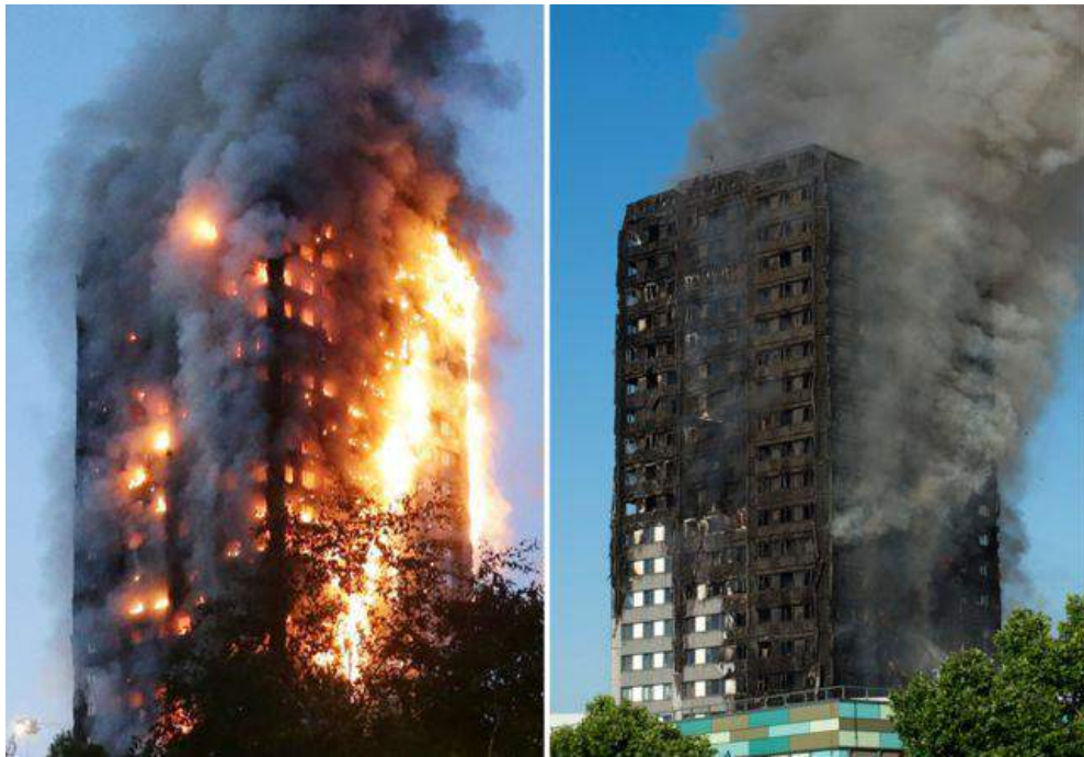
Рис. 1. Пожежа в будівлі Гренфелл-Тауэр, Лондон (Великобританія).
