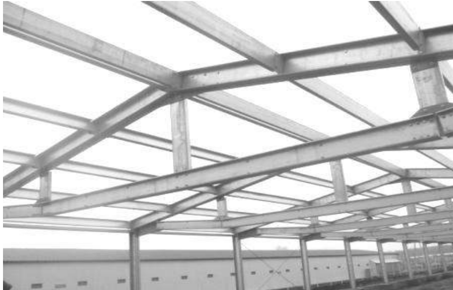
Рис. 1. Загальний вигляд металевої ферми.
