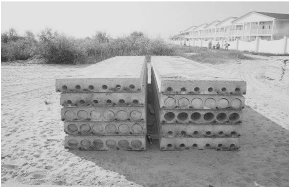
Рис. 1. Загальний вигляд залізобетонної багатопустотної плити перекриття.
