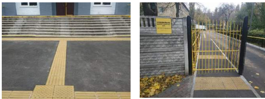
Рисунок 1 – Приклади облаштування тактильної плитки та світловідбиваючого маркування
