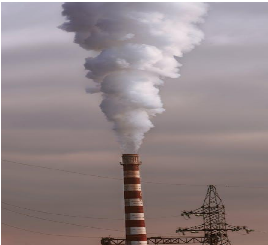
Рисунок 5 – Приклад точкового джерела забруднення (труба)
