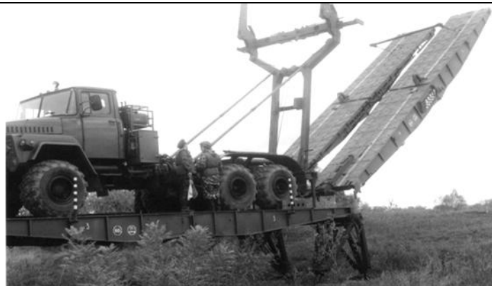
Рис. 17. Важкий механізований міст ТММ-3М у момент укладання мостового блоку
