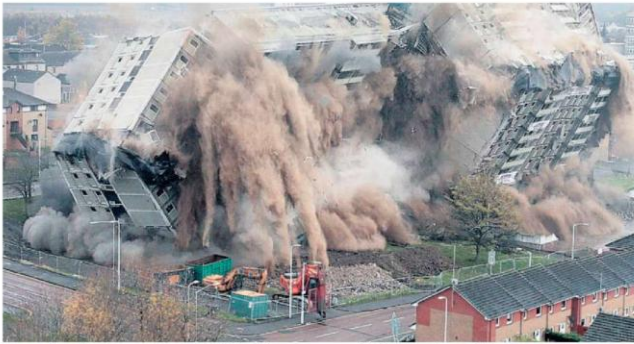
Рис. 1 – Знесення аварійної житлової будівлі вибуховим методом
