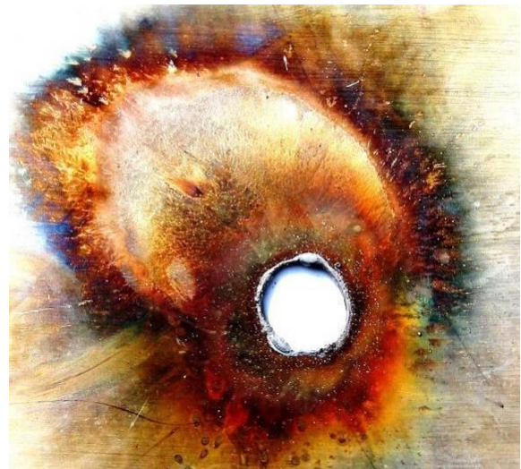
Рис. 15. Внешний вид округлых зон термического воздействия на плоский ИО стальной кровли импульсной A - и длительной C - компонент тока искусственной молнии с нормированными по требованиям [3,4] АВП, сопровождающегося сквозным проплавлением стенки ИО ( h=1 мм; h_a=14 мм)
