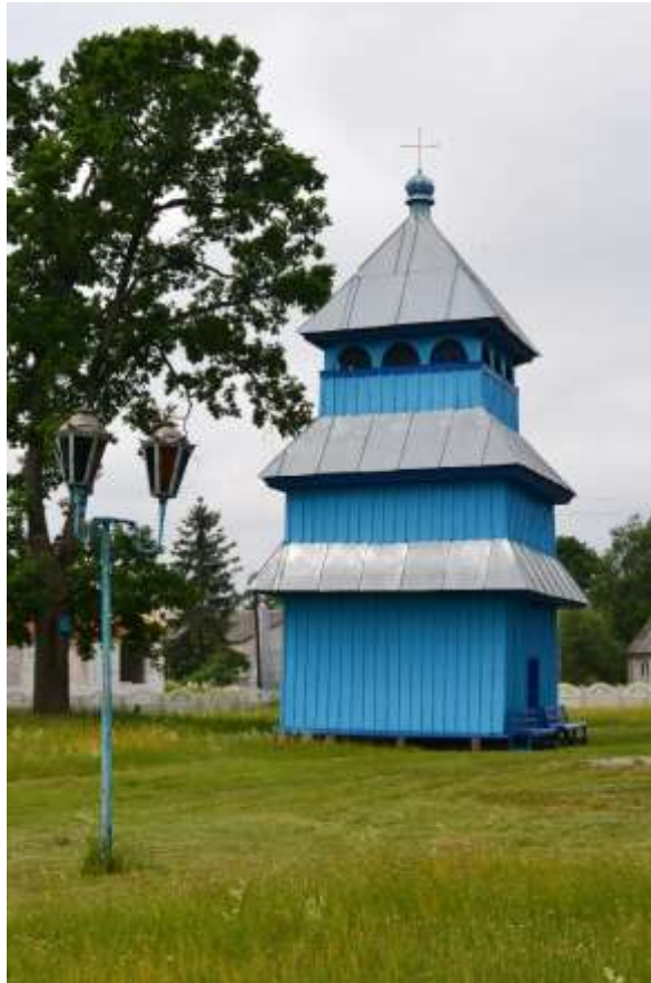
Рис. 2. Дзвіниця церкви Різдва с.Троянівка [5]
