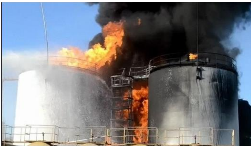
Рис. 1. Фрагмент поширення пожежі в резервуарному парку нафтобази мережі автозаправних комплексів «БРСМ-Нафта»
