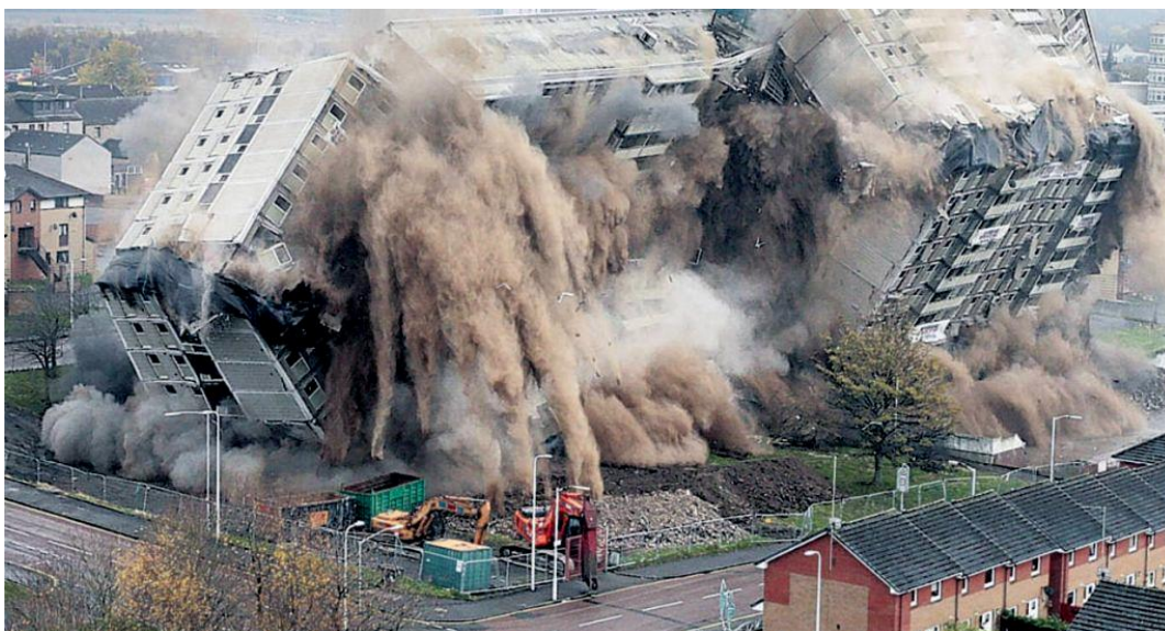
Рис. 1. Знесення аварійної житлової будівлі вибуховим методом
