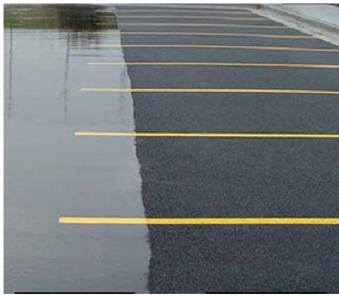
Рис. 1. Порівняння пористого та звичайного асфальту
