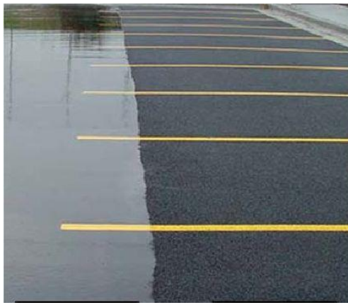
Рис. 1. Порівняння пористого та звичайного асфальту
