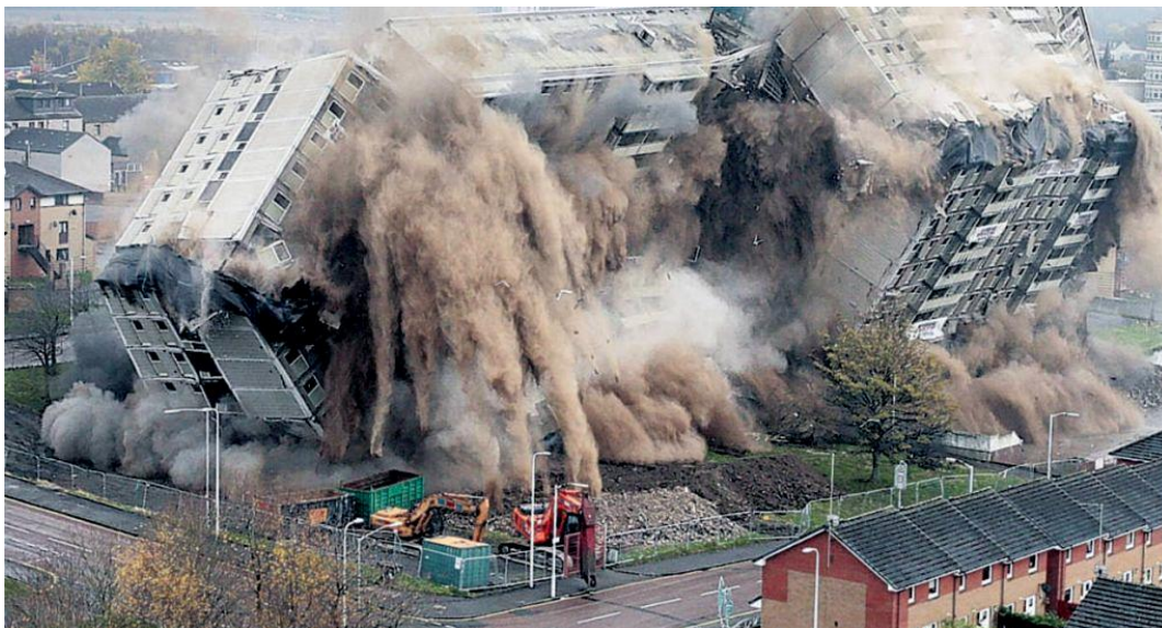
Рис. 1. Знесення аварійної житлової будівлі вибуховим методом
