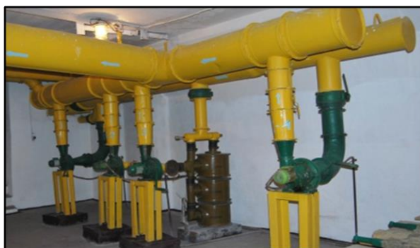
Рис. 20.1. Вигляд фільтровентиляційного приміщення
