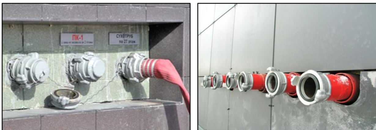
Рис. 13.5. Патрубки діаметром 80 мм для приєднання рукавів пересувних пожежних насосів
