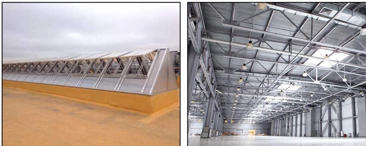
Рис. 9.1. Конструкції верхнього природного освітлення складських будівель
