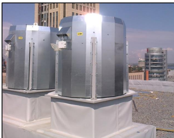
Рис. 14.9. Вентилятор димовидалення даховий
