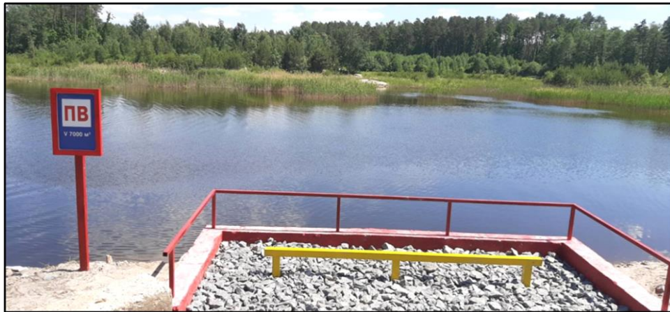
Рис. 6.5. Укрупнений гравієм майданчик для забору води пожежними автомобілями
