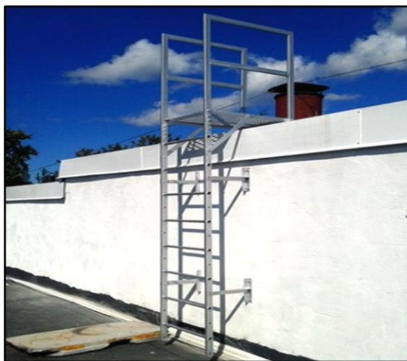
Рис. 4.2. Влаштування зовнішніх пожежних драбин типів П1 у місцях перепаду висот покрівель більше ніж 1 м (не більше 20 м)
