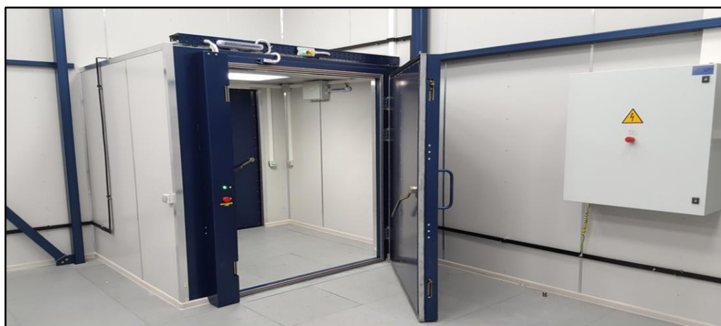
Рис. 8.2. Тамбур-шлюз з постійним підпором повітря
