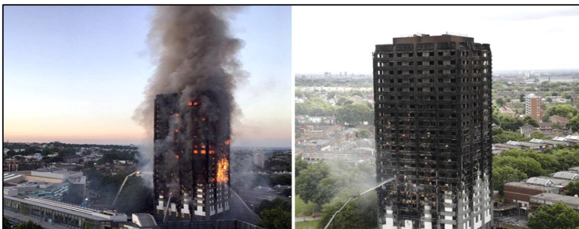
Рис. 2.1. Пожежа в житловому будинках де зовнішня поверхня облицювання зовнішніх стін будинку була виконана з використанням горючих матеріалів
