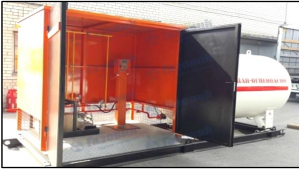
Рис. 22.3. Пункти наповнення та обміну побутових балонів у складі АГЗС
