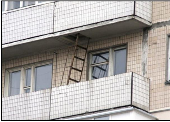
Рис. 14.3. Вихід з балконів (лоджій) квартир або безпосередньо з квартир через двері на зовнішні металеві маршові сходи
