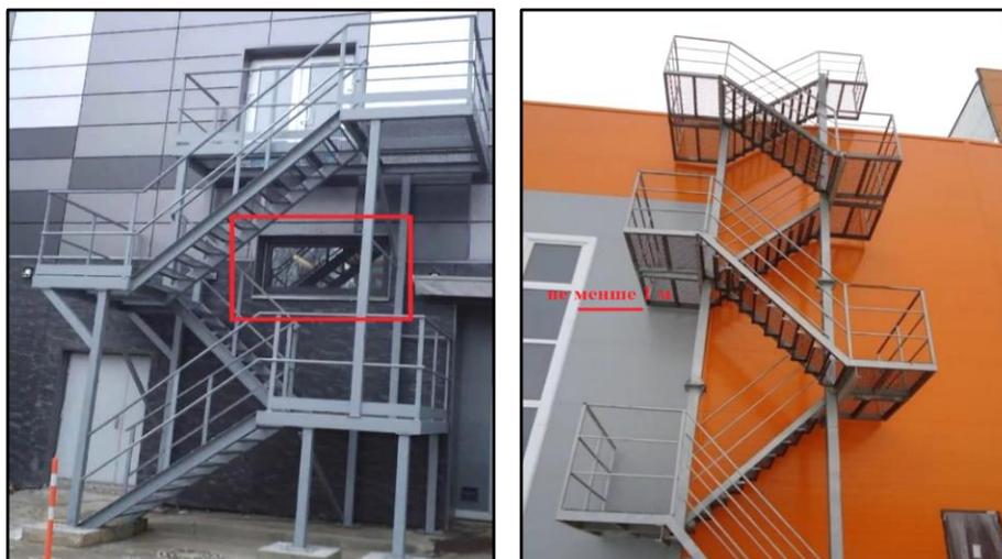
Рис. 4.3. Варіанти не вірного та вірного виконання зовнішніх пожежних драбини
