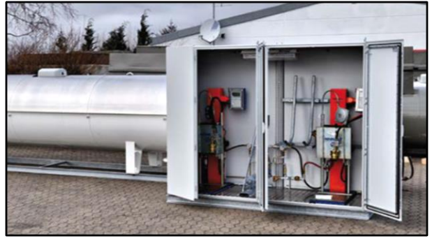
Рис. 22.3. Пункти наповнення та обміну побутових балонів у складі АГЗС
