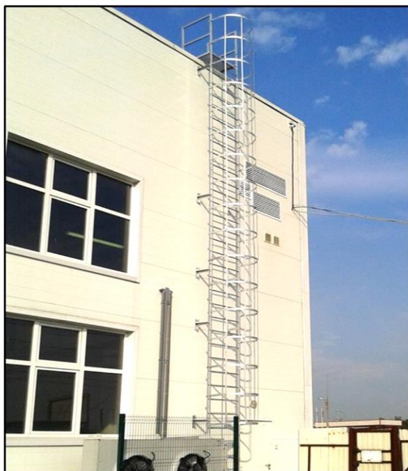
Рис. 8.8. Вихід на покрівлю по зовнішній металевій драбині
