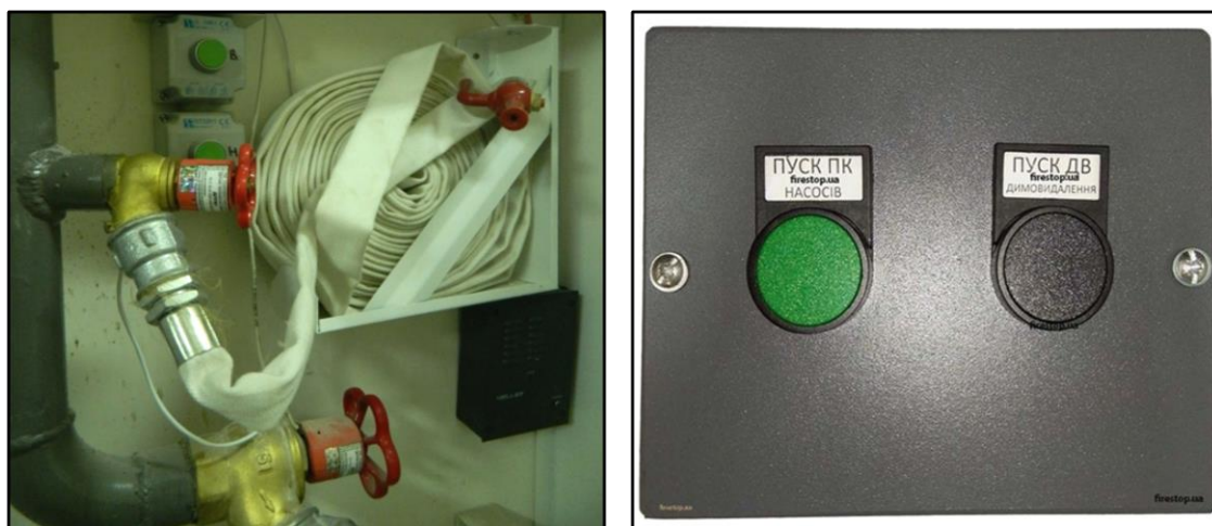
Рис. 11.2. Пожежний кран-комплект з кнопками дистанційного відкриття поповерхових клапанів димовидалення, підпору повітря, запуску пожежних насосів
