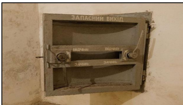
Рис. 20.1. Аварійний тунель з люком
