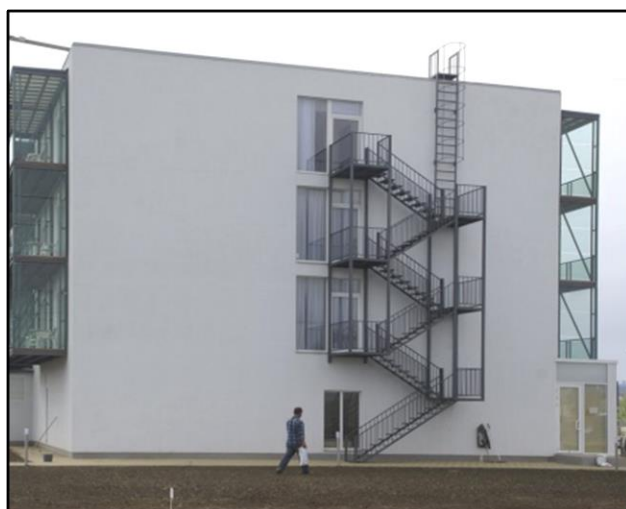
Рис. 14.8. Вихід з житлового будинку на сходи типу С3
