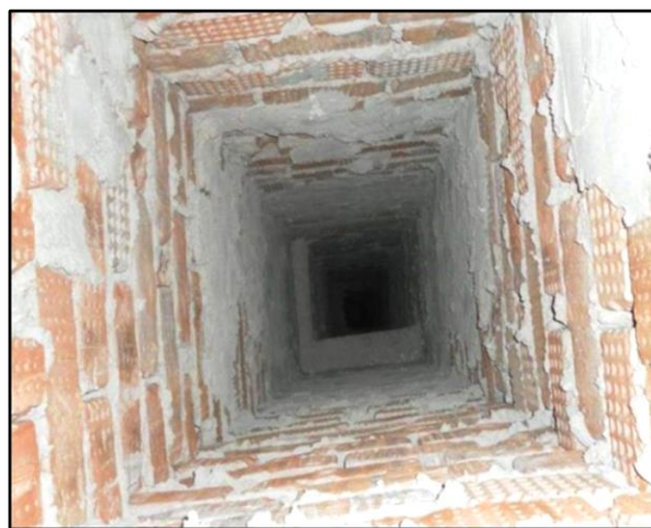
Рис. 14.10. Шахта димовидалення із цегли
