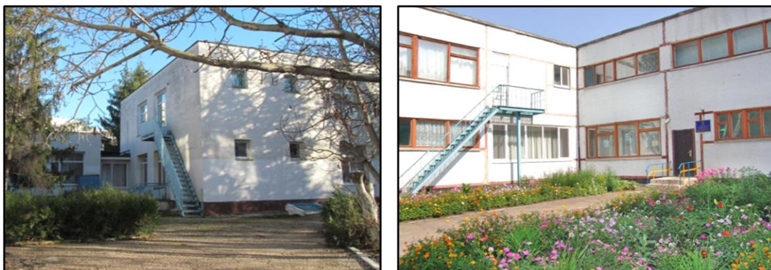
Рис. 16.3. Другий евакуаційний вихід з другого поверху будівлі закладів дошкільної освіти через сходи типу С3
