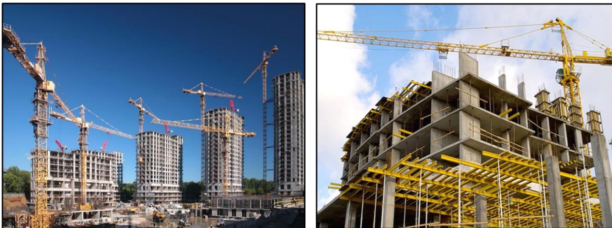
Рис. 1.1. Об'єкти нового будівництва
