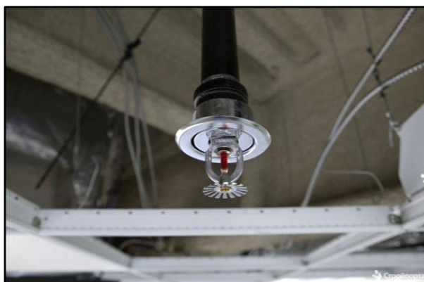
Рис. 13.4. Спринклерні та дренчерні зрошувачі автоматичної системи пожежогасіння
