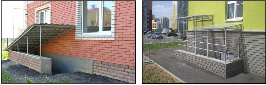
Рис. 11.11. Виходи з підвалів безпосередньо назовні
