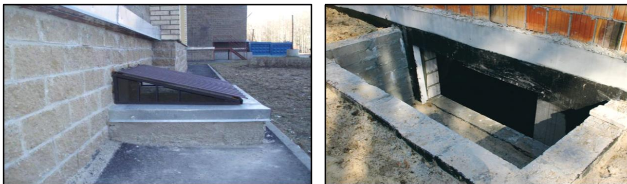
Рис. 14.11. Вікна 0,75 м × 1,2 м з прямиками з підвальних поверхів.
