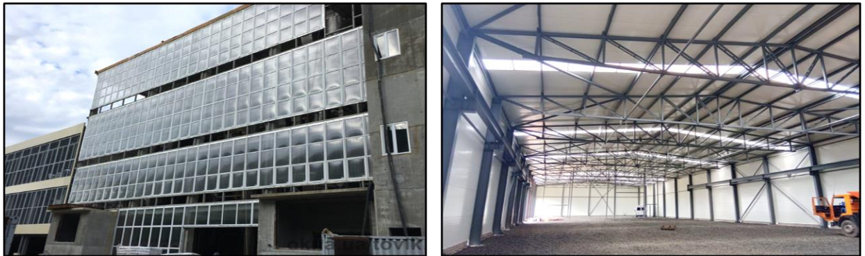
Рис. 9.3. Легкоскридні конструкції складських будівель категорій А, Б
