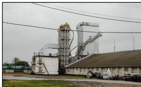
Рис. 10.4. Виходи з будівель елеваторів на зовнішні сталеві відкриті сходи 3-го типу
