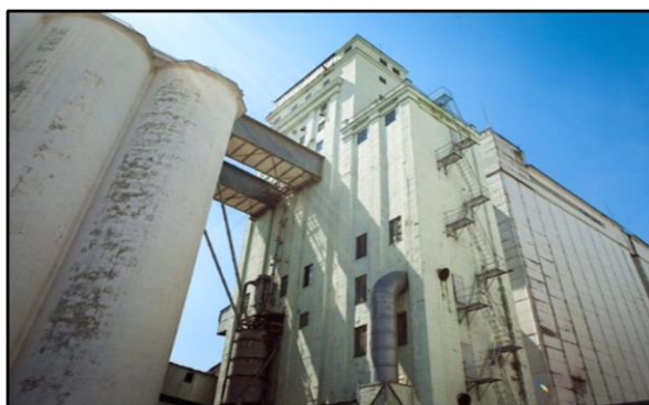
Рис. 10.4. Виходи з будівель елеваторів на зовнішні сталеві відкриті сходи 3-го типу
