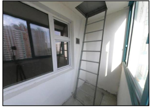
Рис. 14.3. Вихід з балконів (лоджій) квартир або безпосередньо з квартир через двері на зовнішні металеві маршові сходи
