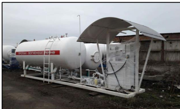
Рис. 22.4. АГЗС з двома надземними резервуарами
