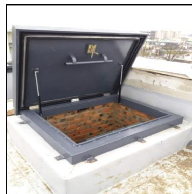
Рис. 2.6. Протипожежний люк
