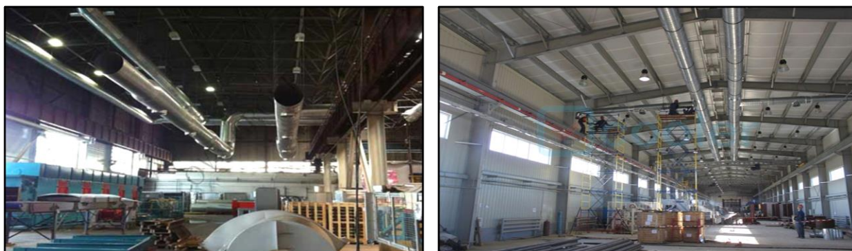
Рис. 2.9. Аварійна вентиляція виробничих приміщень
