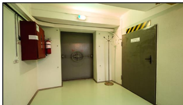
Рис. 20.2. Захисно-герметичні двері
