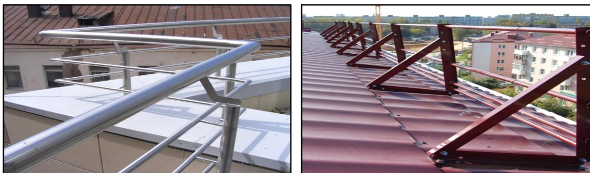
Рис. 4.5. Зображення захисних огорож за периметром покрівель будинків.
