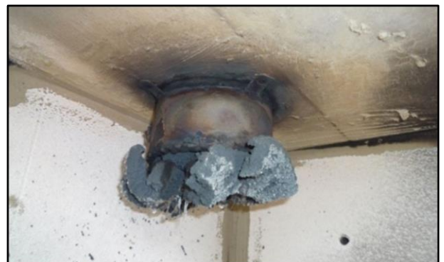
Рис. 21.4. Протипожежна муфта після спрацювання
