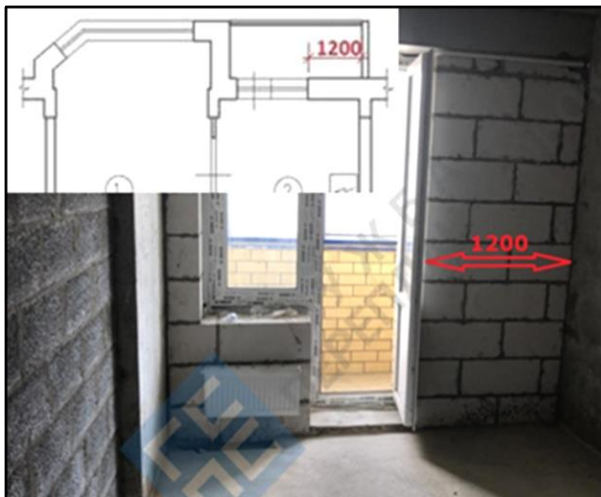
Рис. 14.4. Вихід з квартири на балкон, лоджію з суцільним (без прорізів) простінком завширшки не менше ніж 1,2 м між торцем балкона (лоджії) та прорізом
