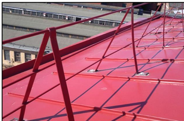
Рис. 8.6. Огородження за периметром покрівлі виробничих будівель
