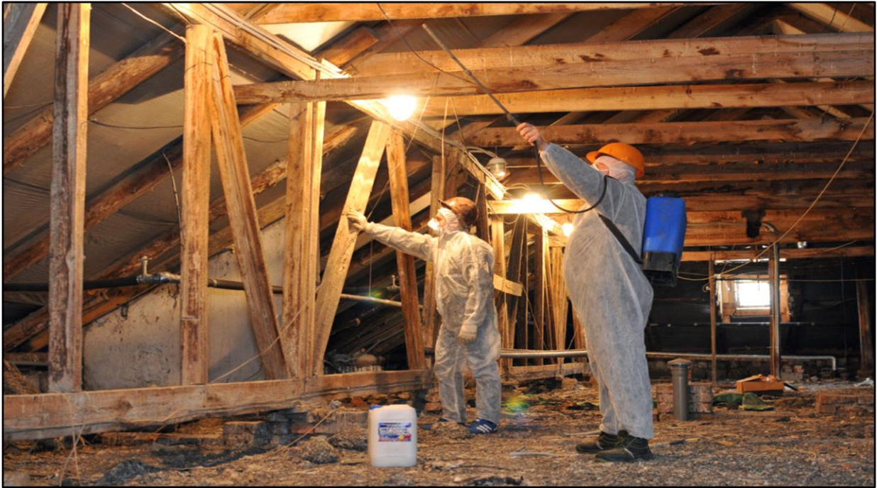
Рис. 2.9. Оброблення засобами вогнезахисту дерев'яних елементів горищних покриттів
