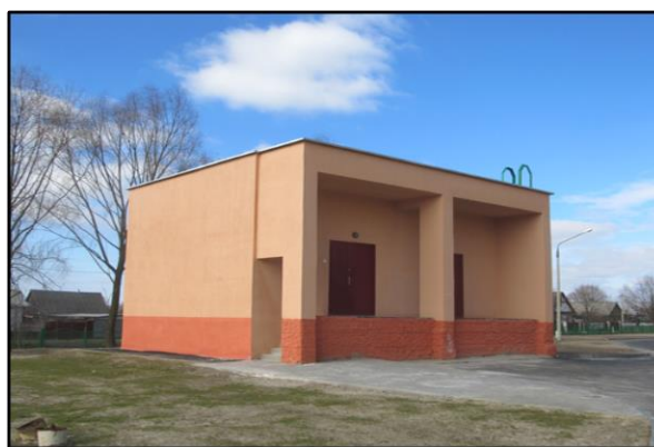
Рис. 17.2. Централізований пункт зберігання і розподілу кисню
