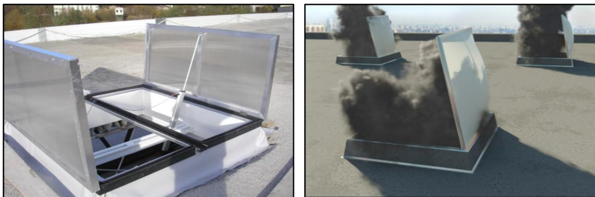
Рис. 13.7. Димові люки у покритті над сценою
