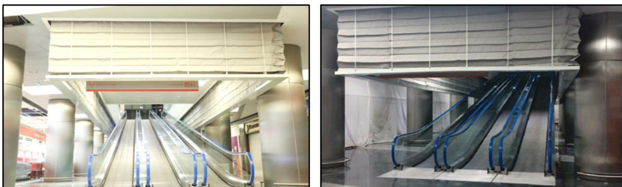
Рис. 2.11. Зовнішній вигляд протидимових завіс
