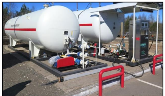
Рис. 22.4. АГЗС з двома надземними резервуарами
