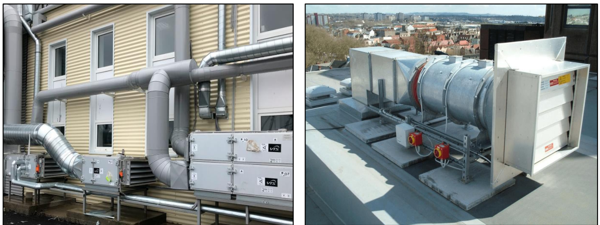
Рис. 3.9. Припливні пристрої систем механічного димо- та тепловидалення
