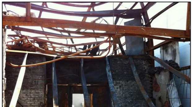
Рис. 7.1. Наслідки руйнування будівель через втрату несучої здатності будівельних конструкцій під дією високих температур
