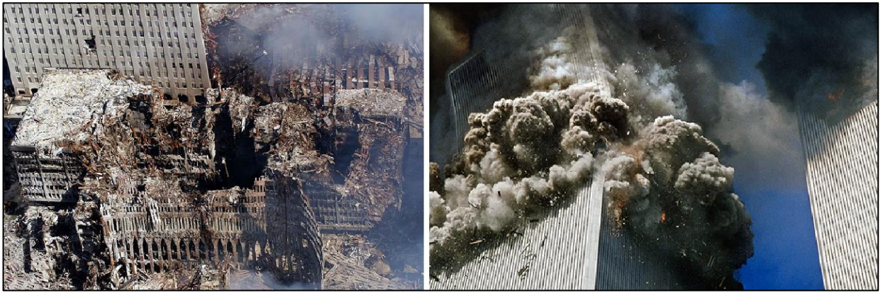
Рис. 2.2. 11 вересня 2001 року США. Руйнування світових торговельних центрів в результаті терористичного акту та ефекту прогресуючого обвалення.
