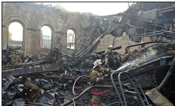
Рис. 7.1. Наслідки руйнування будівель через втрату несучої здатності будівельних конструкцій під дією високих температур
