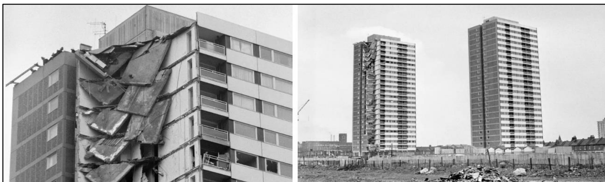
Рис. 2.1. 16 травня 1968 рік, Лондон, наслідки ефекту прогресуючого обвалення конструкцій житлового будинку після вибуху побутового газу в одній із квартир.
