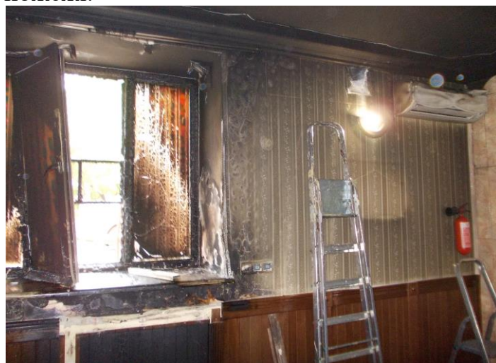
Різні форми ураження конструкцій з полімерних матеріалів – обвуглення елементів віконного блоку та теплова деформація корпусу внутрішнього блоку кондиціонера
