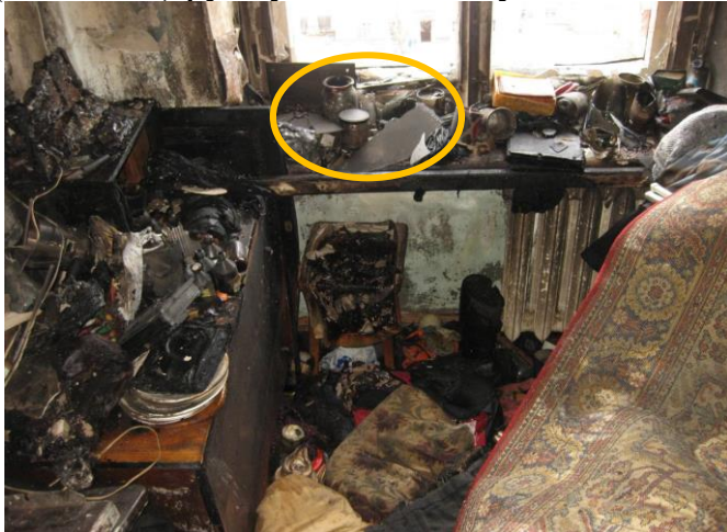
Крупні закопчені уламки віконного скла серед пожежного сміття на підвіконнях у приміщеннях.
