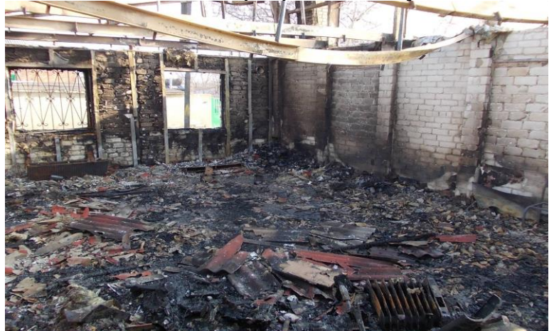
Значна по величині, у порівнянні із іншими однорідними елементами, деформація металевої конструкції у вигляді її прогину та скручування.
