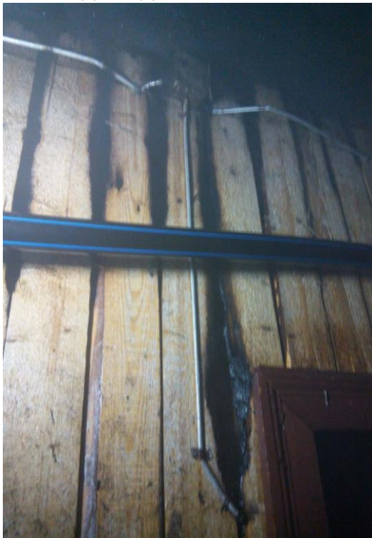
Щілинні прогари у перегородці, що виконана з дерев'яних дощок.
