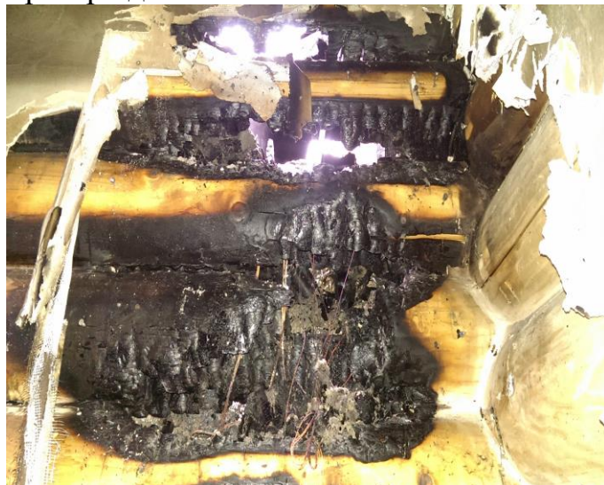
Наскрізні прогари у конструкціях з деревини.
