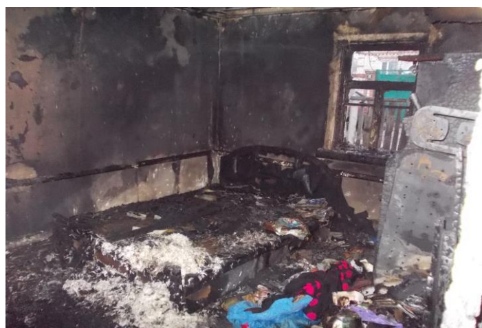
Темні та світлі зони на поверхні штукатурного покриття (поруч із ліжком маються більш світлі зони).
