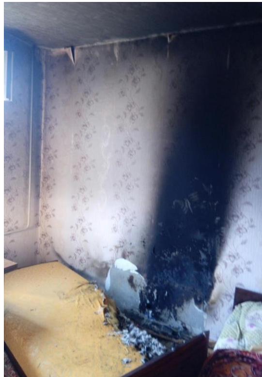
«Осередковий конус», що сформувався шляхом вигорання шпалер та нашаруванням кіптяви.
