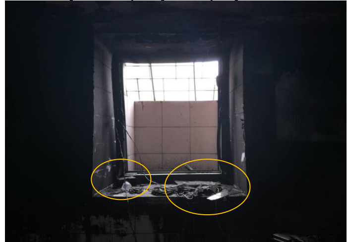
Крупні закопчені уламки віконного скла серед пожежного сміття на підвіконнях у приміщеннях.
