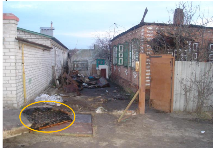
Термічні ураження матрацу, виконаному на пружинному блоці та настільному матеріалі (поролоні) у вигляді вигорання настил очного шару та шару поролону на чітко обмеженій ділянці.
