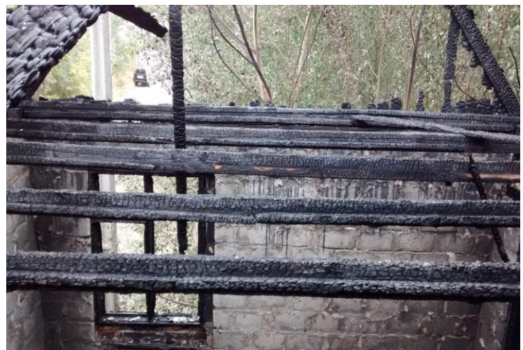
Різний вигляд вугілля на однотипних дерев'яних конструкціях – рихле вугілля з крупними тріщинами на конструкціях, що знаходяться на передньому плані, та щільне вугілля на конструкціях на задньому плані.
