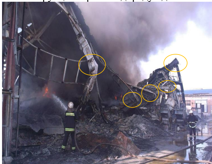
Місця «зламу» однотипних вертикальних конструкцій вказують; конструкції, розташовані у центральній частині, знаходилися ближче до місця утворення первинного вогнища пожежі.
