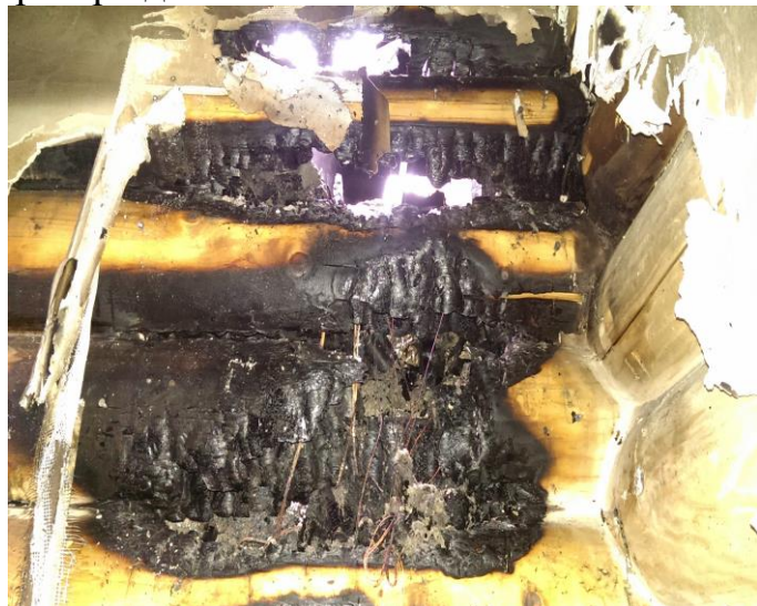
Наскрізні прогари у конструкціях з деревини.
