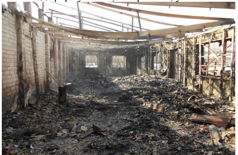
Поступово затухаюча величина деформації однорідних металевих конструкцій (прогин униз) у напрямку від переднього плану фотографії до заднього.
