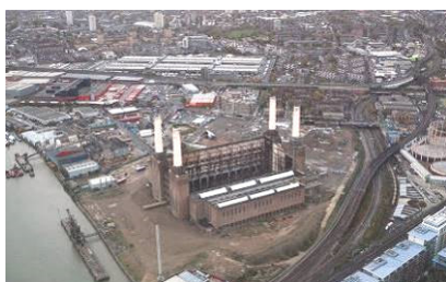
Рис. 2.а. Території до реконструкції.
