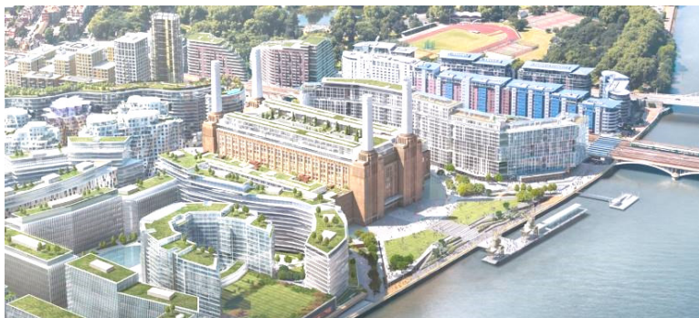
Рис. 2. Ревіталізація території та реконструкція Електростанції Баттерсі у м. Лондон
