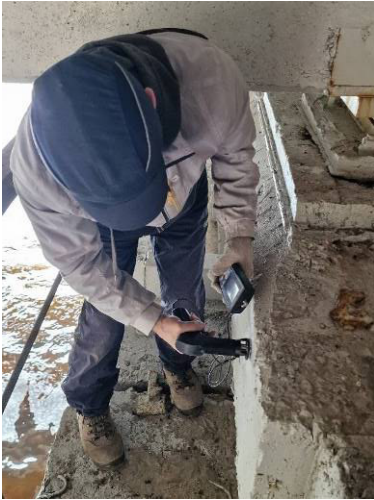
Рис. 3. Визначення міцності бетону ригелів
