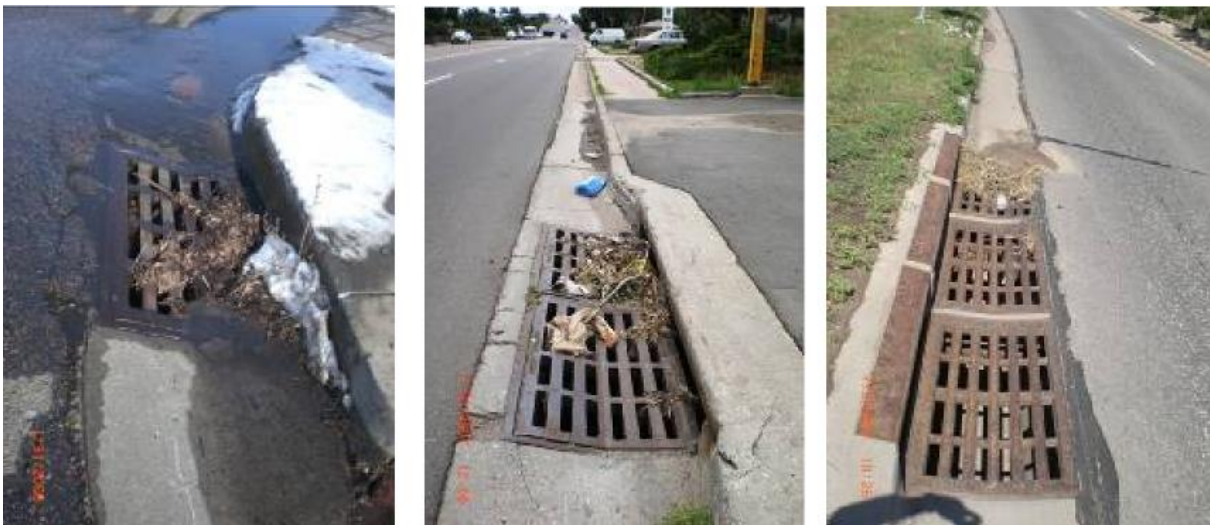
Рис. 1. Засмічені дощоприймачі [6]
