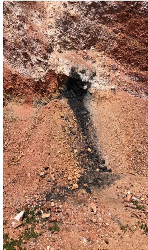
Рис. 2, 3. Процеси руйнування терикону шахти Родинська (рік після закриття)
