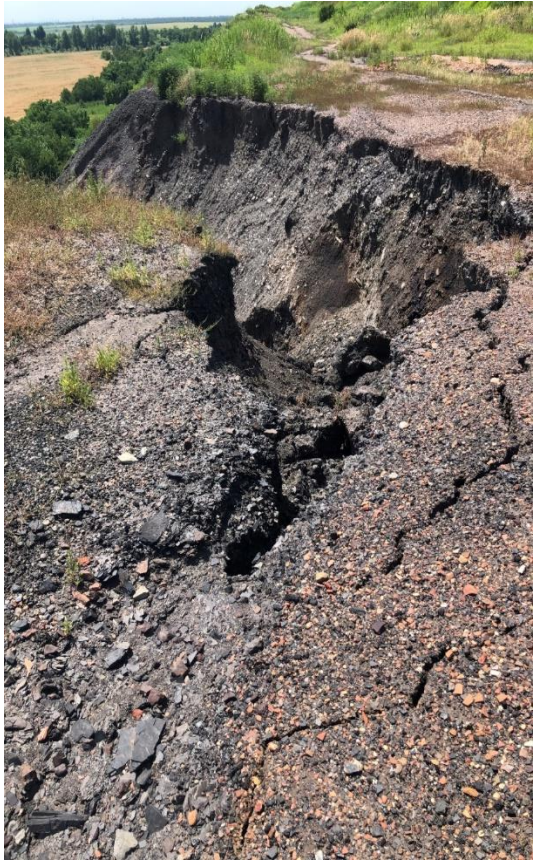
Рис. 2, 3. Процеси руйнування терикону шахти Родинська (рік після закриття)
