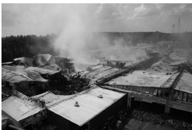
Ryc. 5. Widok z góry zniszczonej hali produkcyjno-magazynowej [2] Fig. 5. Top view of the destroyed production and storage hall [2]
