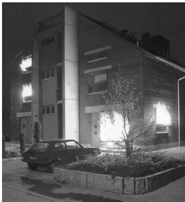
Ryc.1. Budynek do ćwiczeń pożarowych w Landowej Szkole Badenii-Wirtembergii w Niemczech [8]
