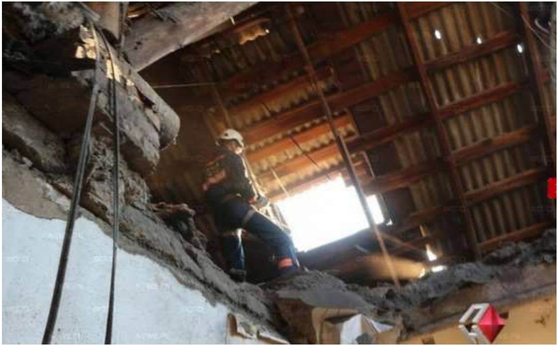
Рис.1 Приклад пожежі у п'ятиповерховому житловому будинку із дерев'яним перекриттям та покриттям.
