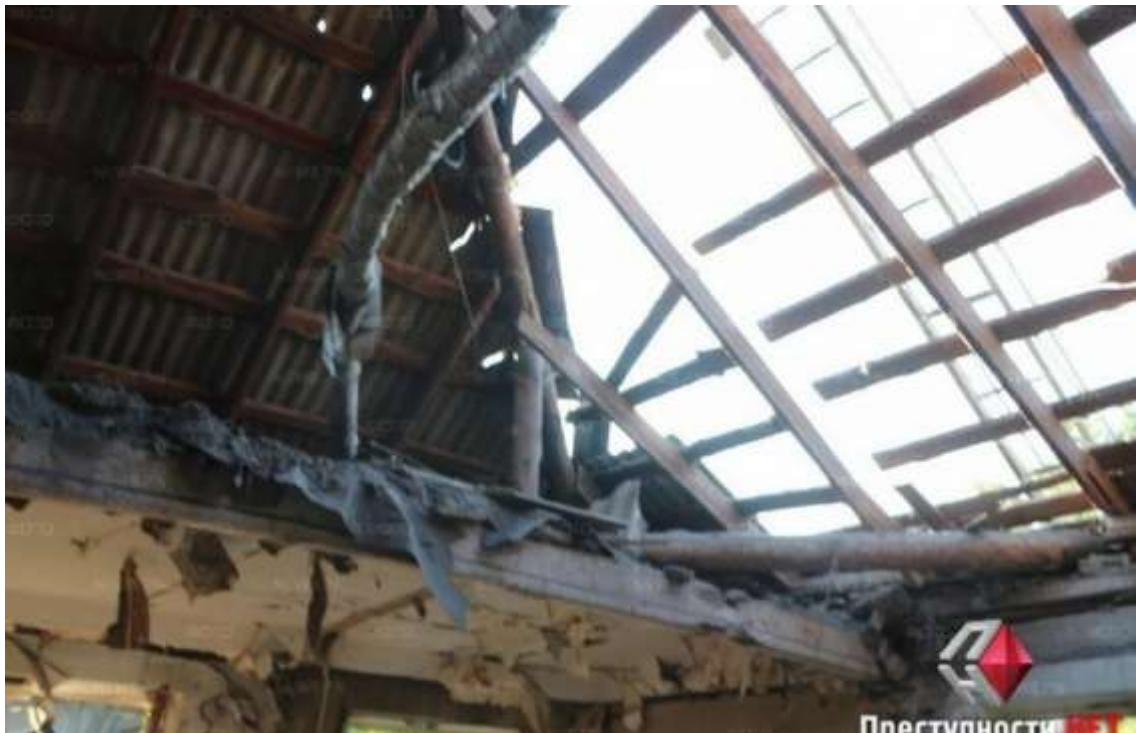
Рис.2. Приклад пожежі у п'ятиповерховому житловому будинку із дерев'яним перекриттям та покриттям.
