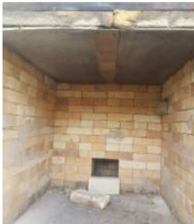
Рисунок 3.4. Отвори для встановлення пальників, один з лівої сторони п-подібного огородження печі та 3 з правої, а також отвір для відведення продуктів горіння
