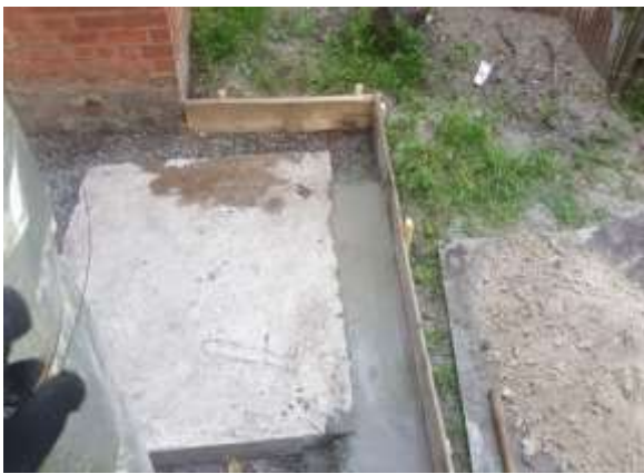
Рисунок 3.2. Створення фундаменту як основи під камеру вогневої печі [90]
