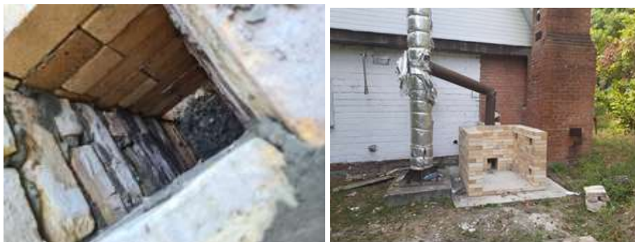
Рисунок 3.5. Димохід камери вогневої печі
