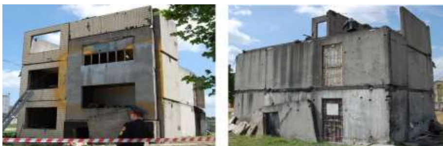
Рисунок 1.3. Повномасштабне пожежне випробування фрагмента великопанельної будівлі
