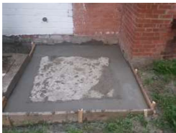
Рисунок 3.2. Створення фундаменту як основи під камеру вогневої печі [90]
