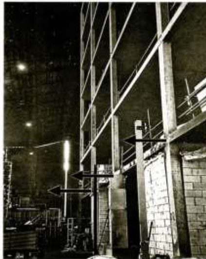
Рисунок 1.1. Випробування на вогнестійкість у Кардінгтоні (Великобританія) 2001 рік: залізобетонна каркасна будівля, пожежне навантаження у вигляді дров, площею пожежі 225 м 2
