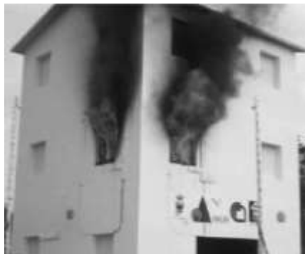
Рисунок 1.2. Повномасштабні вогневі випробування триповерхової дерев'яної будівлі розміром 6,935×6,935 м з пожежним навантаженням у вигляді житлової фурнітури та дров
