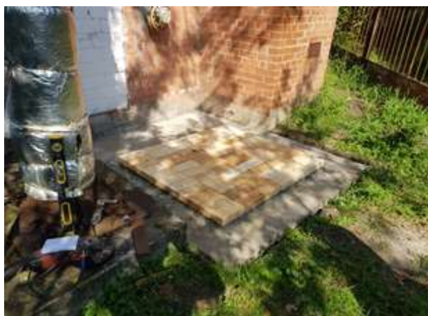
Рисунок 3.3. Піддон камери вогневої печі з вогнетривкої цегли
