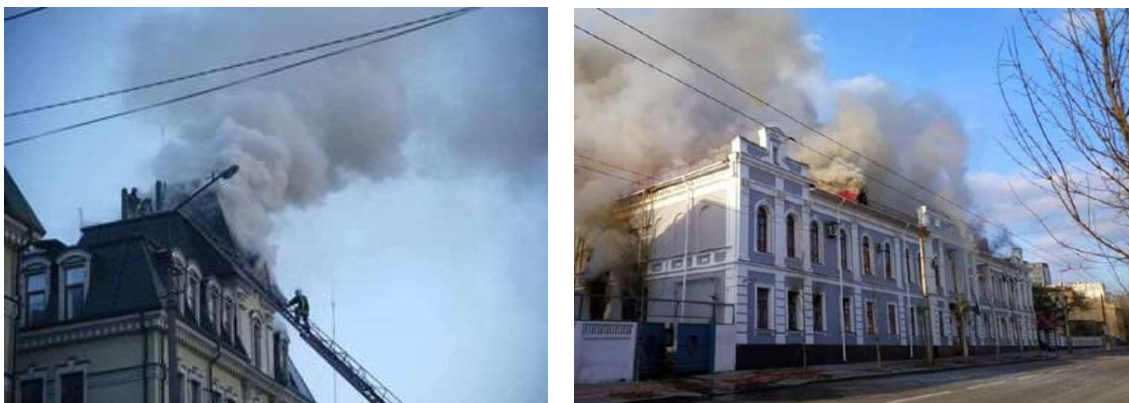
Рис. 1 – Пожежі на покрівлях будівель після попадання на них снарядів (війна росії проти України, 2022 р.)
