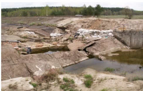
а) состояние берегозащиты
