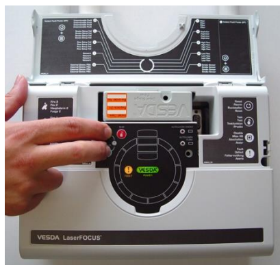
Рис. 2.3.4.6. Аспіраційний димовий пожежний сповіщувач VESDA LASER FOCUS VLF-500
