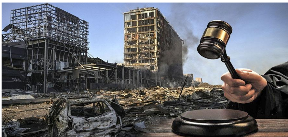
Фото 2 – Повністю зруйноване ракетними і артилерійськими обстрілами місто Авдесвка.
