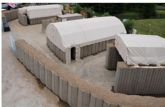
Рис. 2. Варіант мобільних укриттів швидкого зведення з габіонних конструкцій
