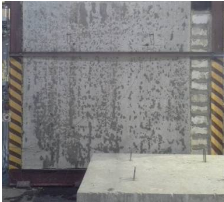
Рис. 4.3. Вигляд залізобетонного стінового фрагменту-зразку №1 після проведення вогневих випробувань.
