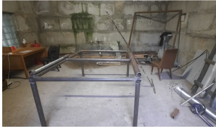
Рисунок 6 – Виготовлена основа конструкції випробувального стенду
