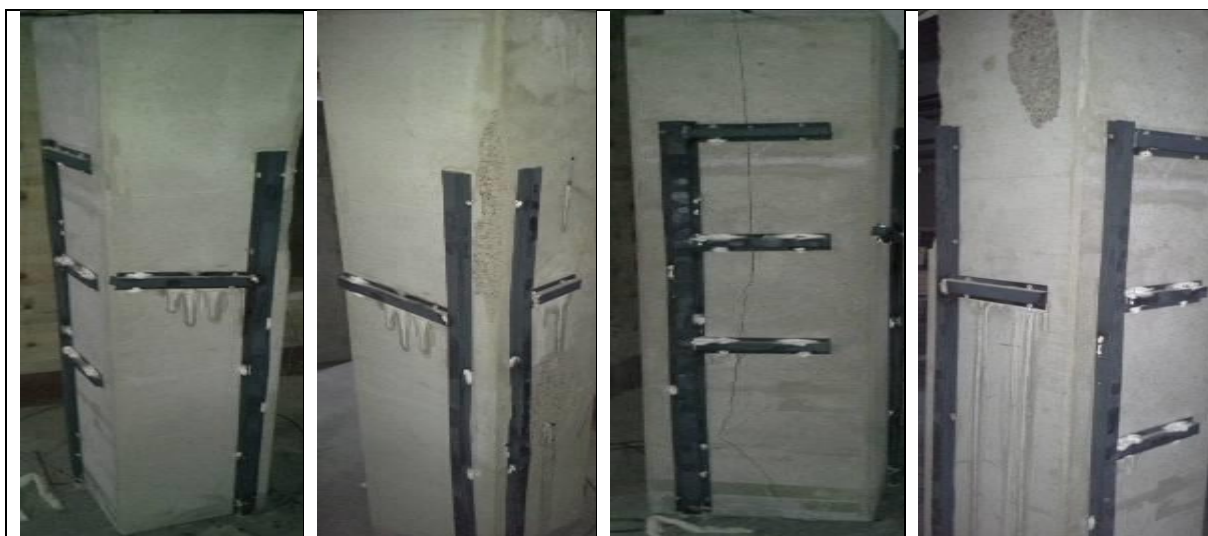
Рис. 4.1. Вигляд залізобетонної колони-зразку №1 з чотирьох боків після проведення вогневих випробувань
