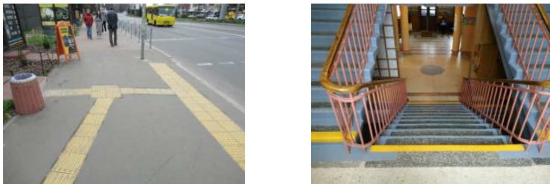
Рисунок 1 – Приклади облаштування тактильної плитки та світловідбиваючого маркування
