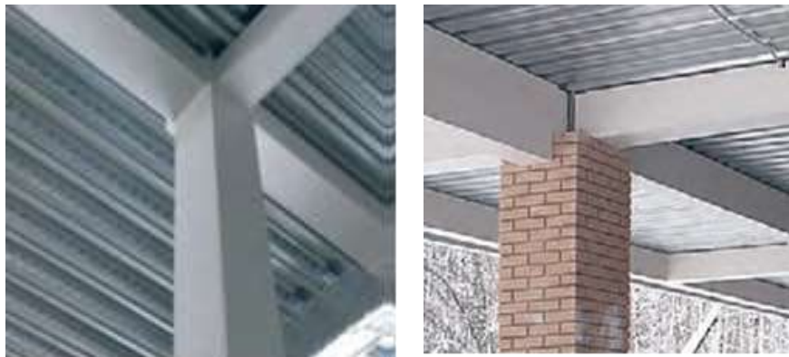
Рисунок 1 – Приклад сталевих конструкцій, захищених шляхом бетонування та облицювання
