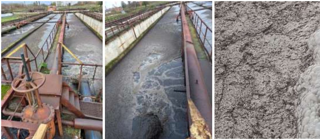
Фото 1 - «Слування» активного мулу після раптового відключення електроенергії на очисних спорудах м. Суми в жовтні 2022 року.
