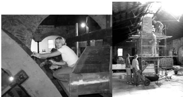
Rys. 5. Realizacja podstawowych zadań Obozów Naukowych: konserwacja koła wodnego i rekonstrukcja pieca pudlingowego
